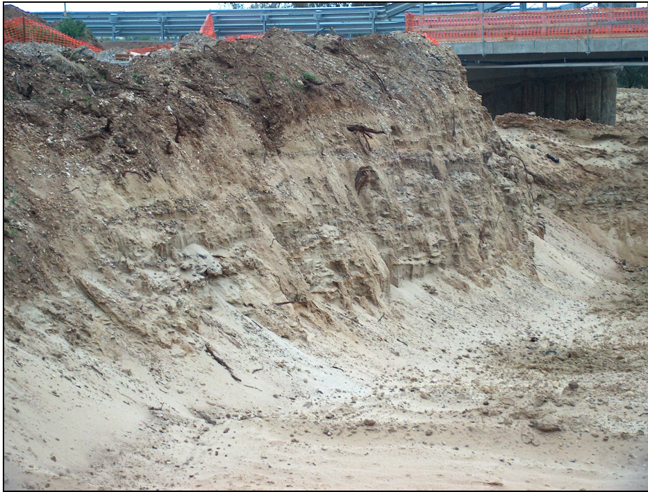
Fig. 4 – Affioramento dell'unità superiore del terrazzo marino T1 durante le operazioni di scavo per la realizzazione dello svincolo di Casinello.
