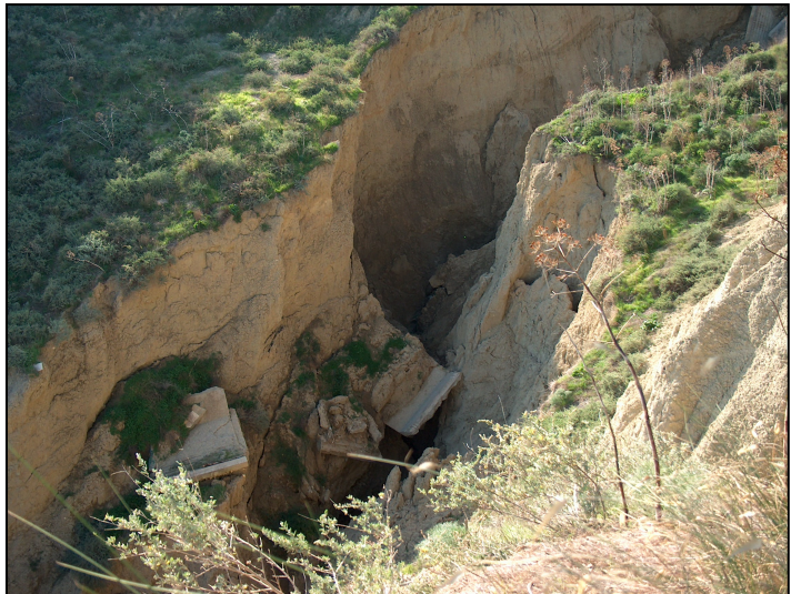
Fig. 8 – Fenomeni di frana lungo il fosso
