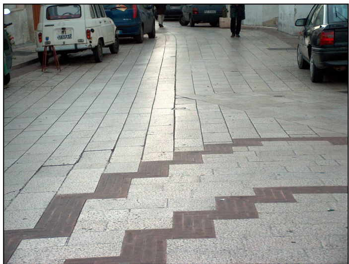
Fig. 6 – Frattura di trazione lungo Corso Margherita
